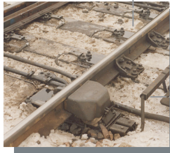
Épingle pour chauffage des verrous carter-coussinets
