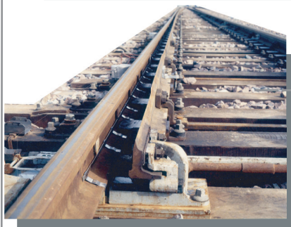
Réchauffage sur appareils de voie UIC 60-60D avec coeur à pointe mobile
